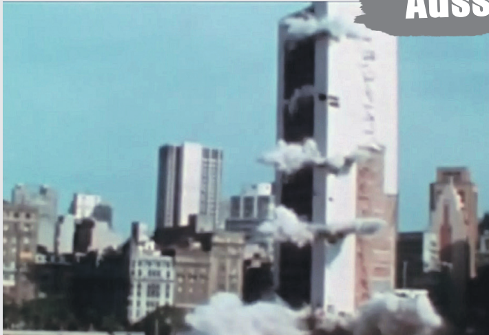
Bei einer kontrollierten Sprengung schiessen oft grössere Trümmerteile aus den Fenstern, die durch Explosionen nach aussen katapultiert werden.
