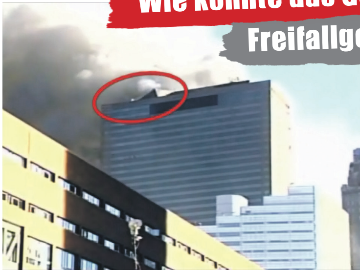
Nach dem Zusammenbruch des Penthouses auf der Südseite des Gebäudes...
