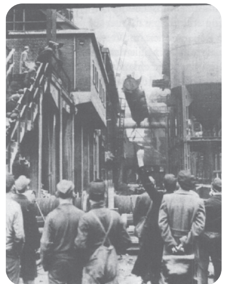
Demontage einer Lehnbohrmaschine 1948 in München
