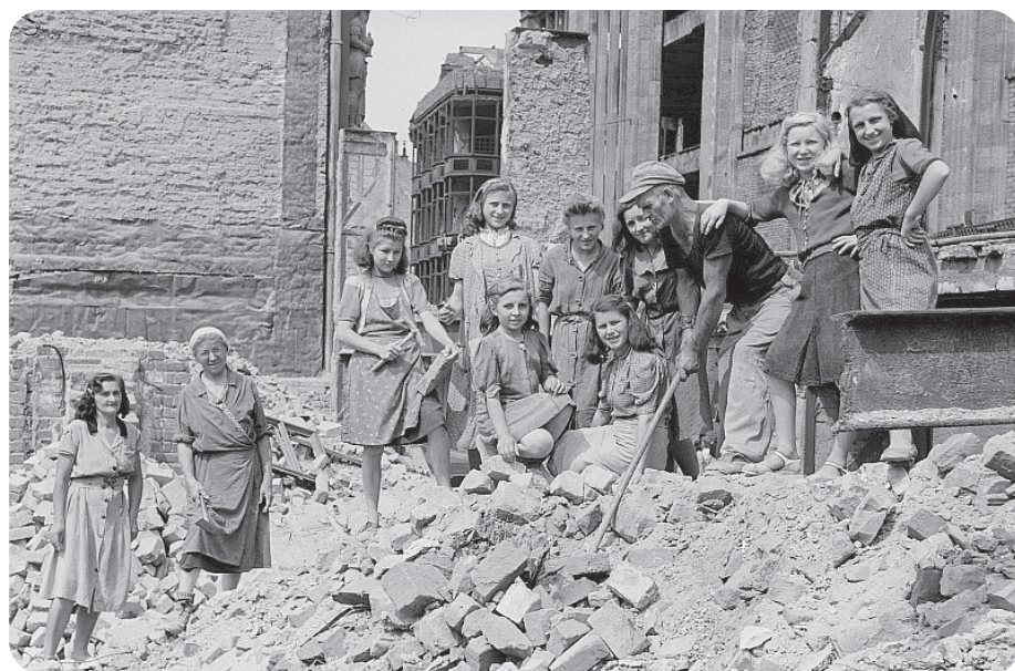
Die wohl entscheidende Antriebskraft des Wiederaufschwungs waren der Wille und der Einsatz aller Schichten der deutschen Bevölkerung (hier die unermüdlichen «Trümmerfrauen» im Einsatz).
