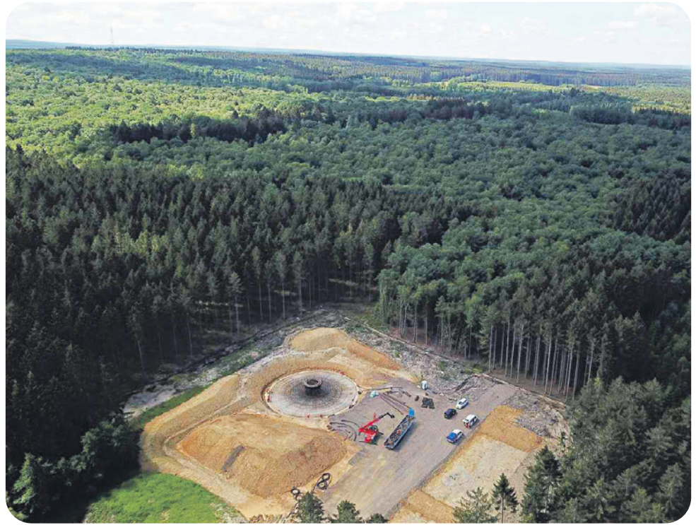
Bau eines Windrades im Wald: Windräder nehmen optisch keine grosse Fläche ein. Da sie aber ein grosses, stabiles Fundament brauchen, müssen für den Bau ganze Waldstücke gerodet werden. Dabei bleibt es in der Regel nicht nur bei einem Windrad. Die gefälltten Bäume hätten eine grosse Menge CO 2 aufgenommen.
