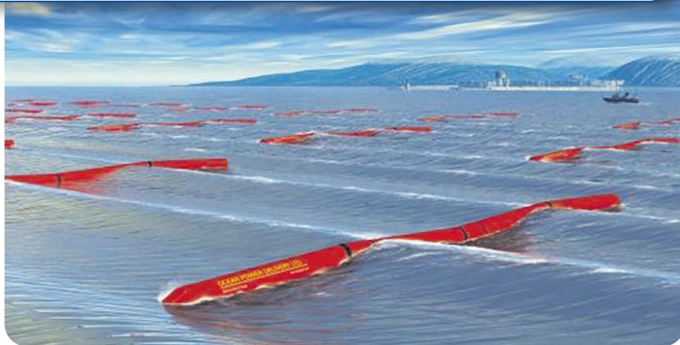
Das Prinzip der Wellenkraftwerke: Hintereinander verbundene Schwimmkörper («Seeschlangen») verändern ihre Lage und auf diese Weise erzeugter Druck kann in Strom verwandelt werden. Viel Strom generiert man damit nicht, dafür ist die Instandhaltung kompliziert und kostspielig.
