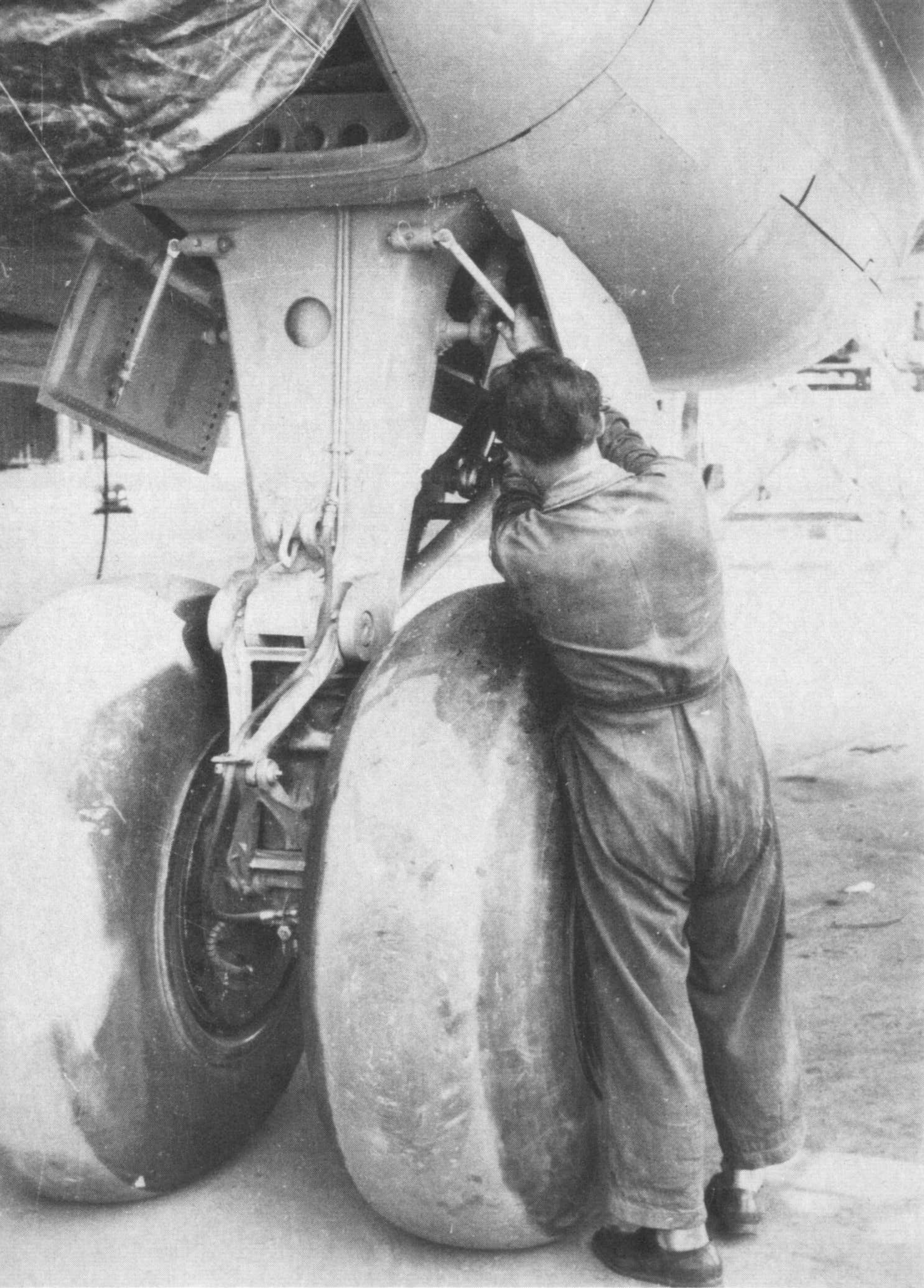
Fahrwerksmontage Ju 290 bei Letov.
