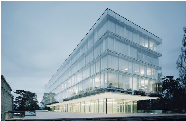
Abb. 3.9: Erweiterung der Hauptverwaltung Welthandelsorganisation WTO | wittfoht architekten bda | Genf (CH) | 2013
