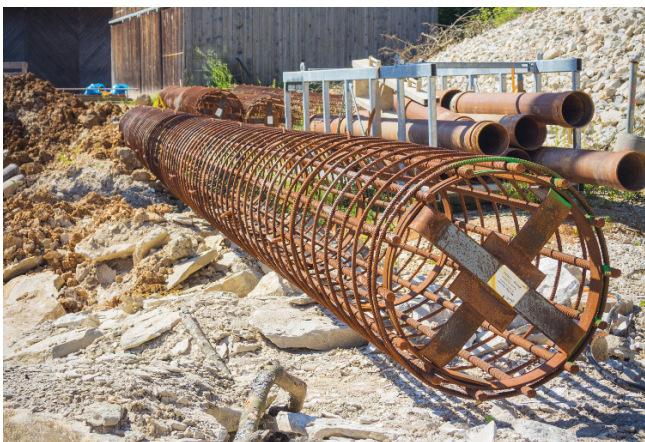
Abb. 4.21: Herstellung eines Großbohrpfahls (oben) und vorgefertigter Bewehrungskorb (unten)
