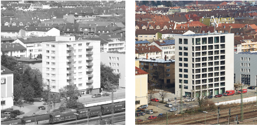
Abb. 1.4: Revitalisiertes Wohnhochhaus mit Aufstockung „Güterstraße 30“ | Freivogel Mayer Architekten | Pforzheim [D] | 2014
