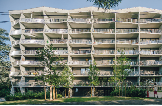
Abb. 3.11: Wohngebäude Jolimont | Nomos | Genf (CH) | 2015
