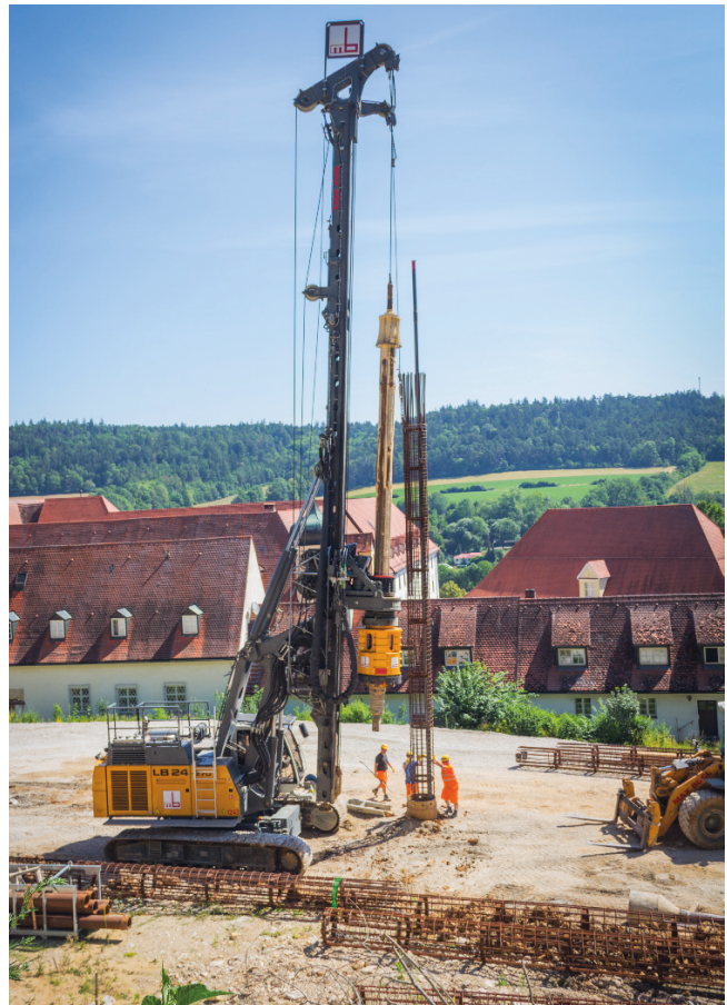
Abb. 4.22: Einbringen des Bewehrungskorbes zur Herstellung eines Großbohrpfahls.
