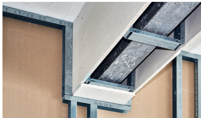
Abb. 4.17: Kastenförmige Verkleidung eines Stahldeckenträgers mit Gips-Feuerschutzplatteng
