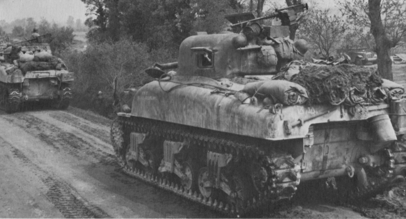
Zwei M4A1 der 1. Panzerdivision in einem getarnten Biwakraum bei Anzio am 20. Mai 1944. Obwohl die Panzer eingegraben sind, können sie, falls notwendig, schnell aus ihren Gräben herausziehen. Interessant die zusätzlichen Panzerplatten hinter den Luftfiltern.
