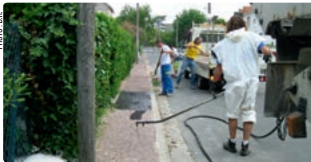
▼ Travaux de gravillonnage.
