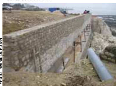
▼ Ni la neige, ni la grêle n'ont eu raison de la construction du mur
