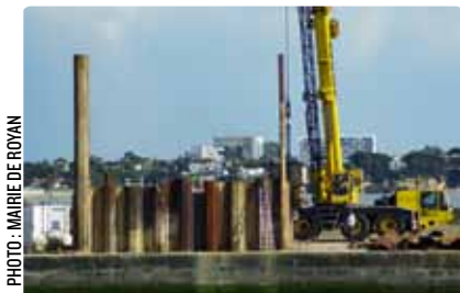
▲ Mise en place des « palplanches » (coffrage des cuves enterrées)
