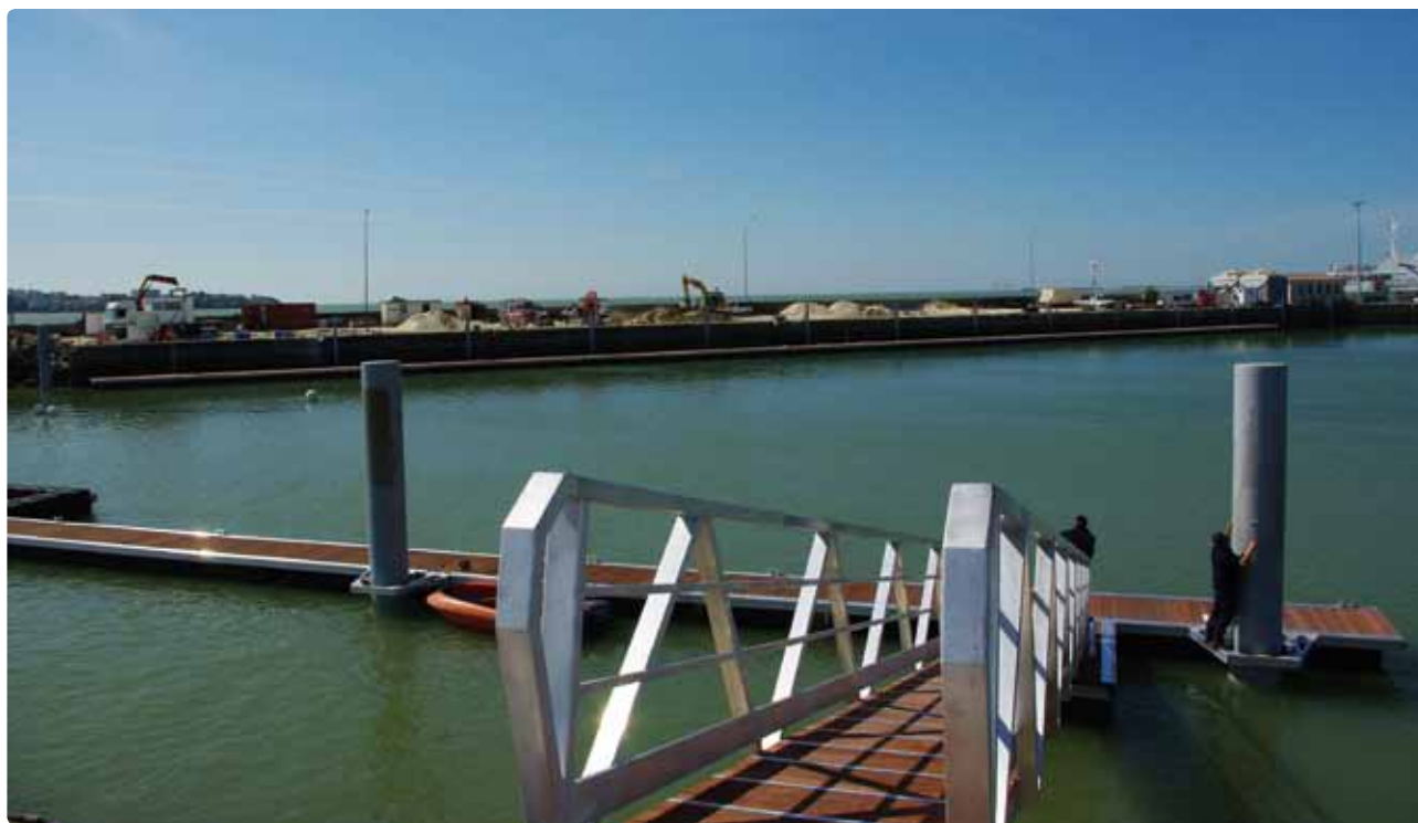
▼ Une partie des nouveaux pontons
