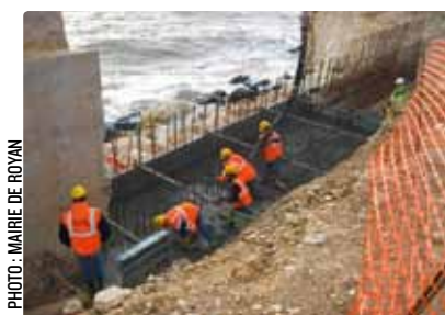
▼ Socle de béton armé contre vents et marées
