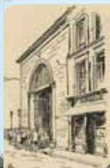
◀ La façade du marché
